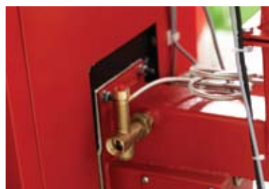
Typowy montaż BVTS jako zabezpieczenie kotła przed cofnięciem się płomienia
